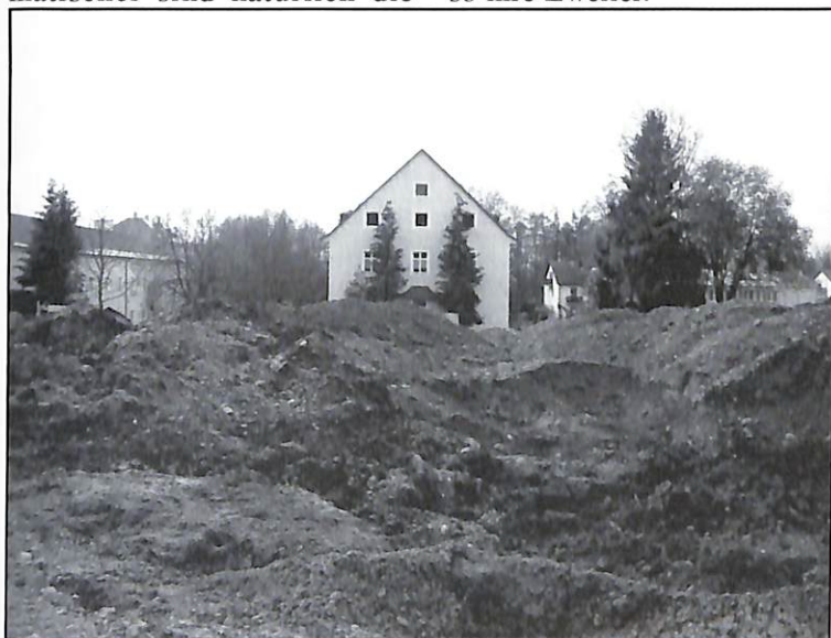
Nicht mehr wieder zu erkennen ist das mit viel Liebe angelegte und gepflegte Gelände um Schloss Zinneberg. Derzeit - und noch bis auf Weiteres - werden alte Leitungen erneuert.
