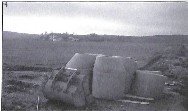
Die Arbeiten im Gewerbegebiet Steinhausen sind schon zügig voran gekommen. In einer Dienstbarkeitsbestellung sind die Details geregelt, um ein Zusammenhang von Reinstorf und Steinhausen auch künftig zu vermeiden.
