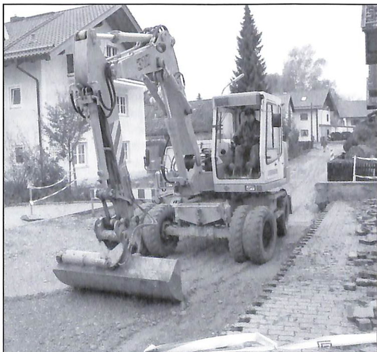
Die Arbeiten an der Niedermairstraße gehen rasch voran. Hier soll eine Einbahnstraßenregelung gelten. Foto: kk
