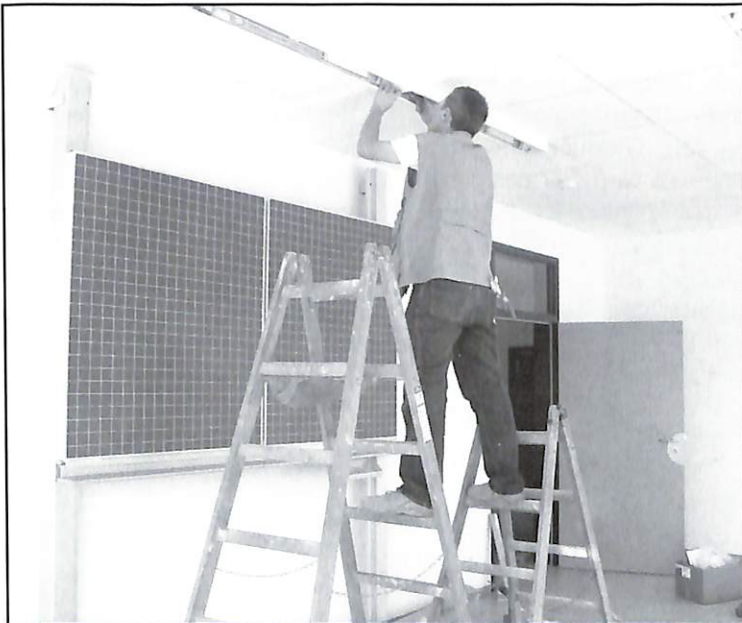
Am Freitag vor Schulanfang wurden die elektrischen Installationen fertig gestellt und nach einer großen Endreinigung konnten die Schüler der achten und neunten Klassen einziehen.
