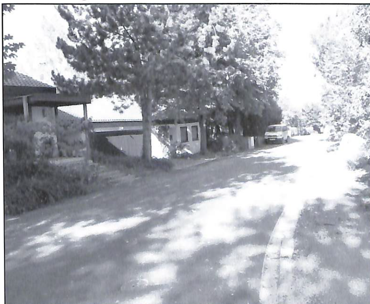
Der Eichenweg in Haslach nach der Sanierung: Reduziert von 7 auf 4,50 m Breite und eine Regenwasserversickerung im Randstreifen. Foto: kk
