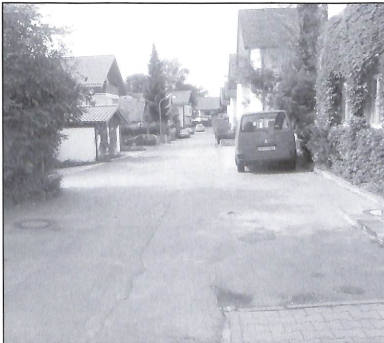
Die Sanierung der Niedermairstraße würde laut Angebot gut 86.000 Euro kosten. Die Maßnahme wurde zurückgestellt. Foto: kk
