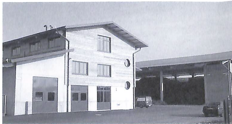
Das Biomasse-Heizkraftwerk in Sauerlach ist im ersten Jahr in Betrieb. Inzwischen sind mehr als die Hälfte aller Haushalte und ein Großteil der Gewerbebetriebe angeschlossen. Eine Glonner Delegation des Gemeinderates besichtigte die Anlage im März dieses Jahres.
