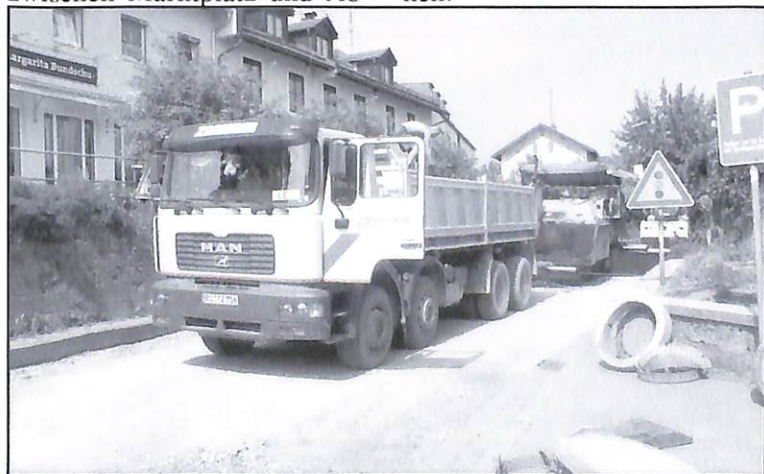
Schwer gearbeitet wurde drei Tage lang an dem sanierungsbedürftigen Teilstück der Prof.-Lebsche-Straße in der Ortsmitte. Die Sperrung war aber nur von kurzer Dauer. Foto: kk
