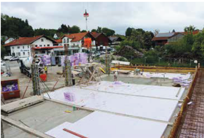
Bodenplatte der Fahrzeughalle.
