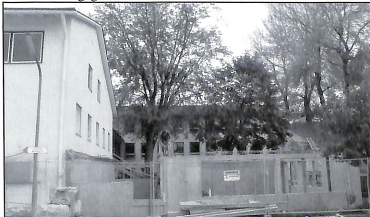
Gewaltige Bau-Fortschritte sind derzeit bei der Schulhauserweiterung zu beobachten. Foto: kk
