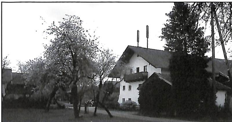
In Balkham gelegen ist ein Standort für zwei Mobilfunksender. Diese Anlage kann auch für E-plus verwendet werden. Foto: sk
