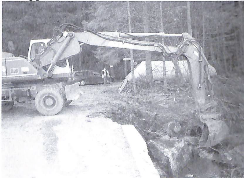
Die Brücke zwischen Reisentäl und Münster ist mittlerweile saniert - der Zweckverband zur Unterhaltung von Gewässern III. Ordnung hat bei der Wiederherstellung und Renaturierung des Augrabens-Durchflusses mitgeholfen.
