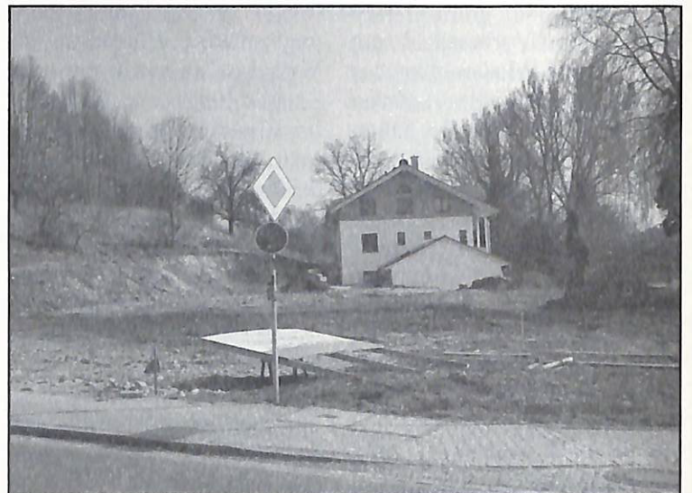
Ein Wohn- und Geschäftshaus entsteht derzeit auf dem Gelände des alten Sattler-Huber-Hofes. Foto: kk
