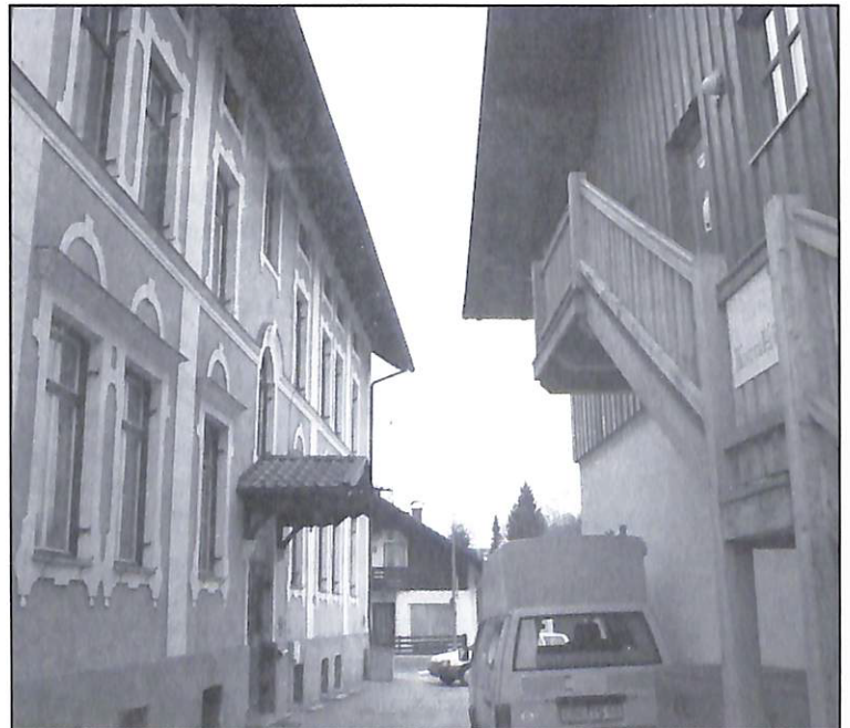
Viele Nutzer sind in der Klosterschule unter einem Dach untergebracht - die Raumverteilung wurde jetzt im Hinblick auf den geplanten Schulhausanbau und das daraus folgende Raumangebot aktualisiert. Foto: kk
