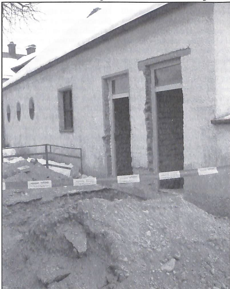
Für das öffentliche WC im Leichenhaus wurde im Februar der Kanalanschluss hergestellt. Bei der Überprüfung hatte sich zuvor herausgestellt, dass das Gebäude nur über ein 1,50 Meter langes Blindrohr verfügte. Foto: kk
