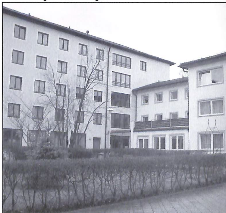
Das Marienheim ist einer der großen Anschließer für das Biomasseheizwerk Glonn. Auf dem Gelände der Caritas am Bernesterrfeld soll auch das Heizwerk gebaut werden.
