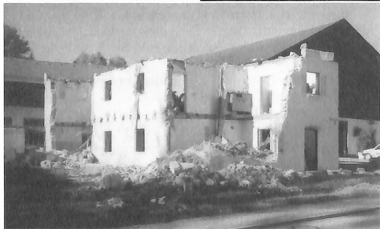
Inzwischen ganz abgebrochen: An der Kastenseestraße erweitert demnächst das Autohaus Jehl. Foto: kk
