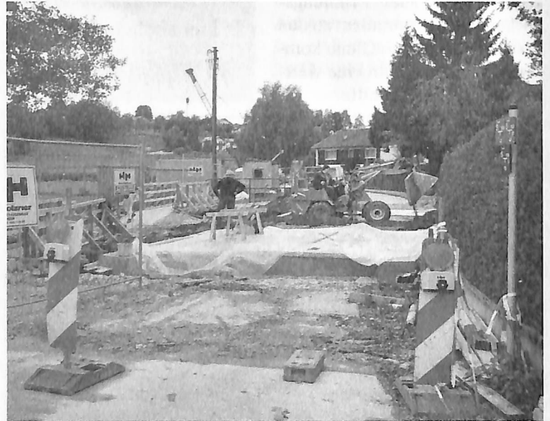
Der Brückenbau belastete den Gemeindehaushalt in den vergangenen Jahren beachtlich. An der Wiesmühlstraße wurden darüber hinaus auch noch Parplätze für Wanderer angelegt. Foto: kk
