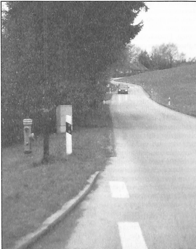
Zwischen der Einmündung Wiesmühlstraße bis zum Fußweg nach Balkham wird das erste Stück des Gehwegs entlang der Kastenseestraße fertiggestellt.
