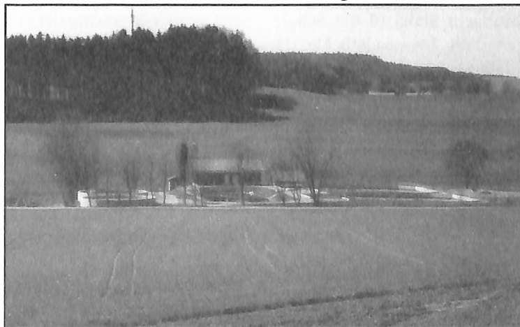
Unter anderem bei der Belüftung der Becken gab es Schwierigkeiten mit der neuen Kläranlage. Foto: kk
