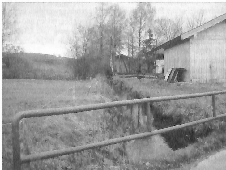
Wenn alle noch ungenutzten Möglichkeiten zur Versickerung ausgenutzt würden - hier am Schrankenbach in der Filzen - könnte das nächste Regenrückhaltebecken mindestens eine Nummer kleiner ausfallen. Foto: kk
