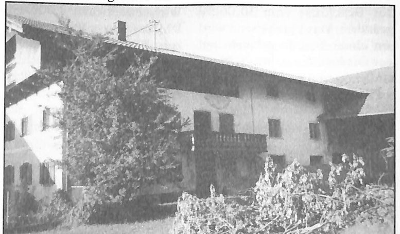
Der rückwärtige Teil dieses alten Bauernhofs in Schlacht wird abgebrochen und durch zwei Gewerbeeinheiten ersetzt werden. Foto: kk
