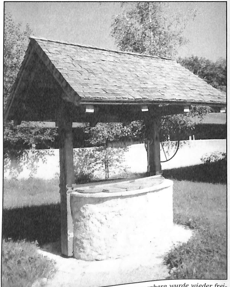
Auch der Brunnen neben der Kapelle in Georgenberg wurde wieder freigelegt und restauriert. Foto: kk
