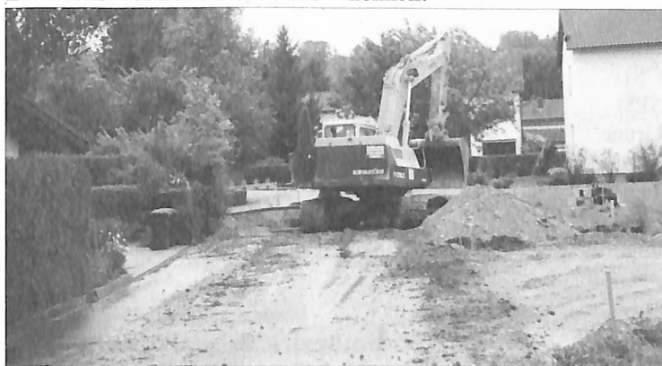
Im Zuge der Erschließungsmaßnahmen für das Baugebiet Kugelfeld-/Wiesmühlstraße kommen die Kanalbauarbeiten gut voran. Foto: kk
