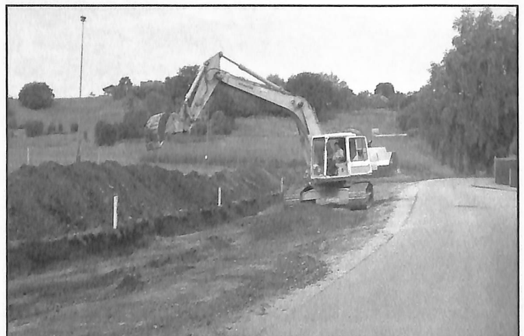
Abgerissen und wieder neu erstellt werden die beiden Brückenbauwerke an der Wiesmühle. Für Ausflügler gibt 's dann 20 neue Parkplätze. Foto: me
