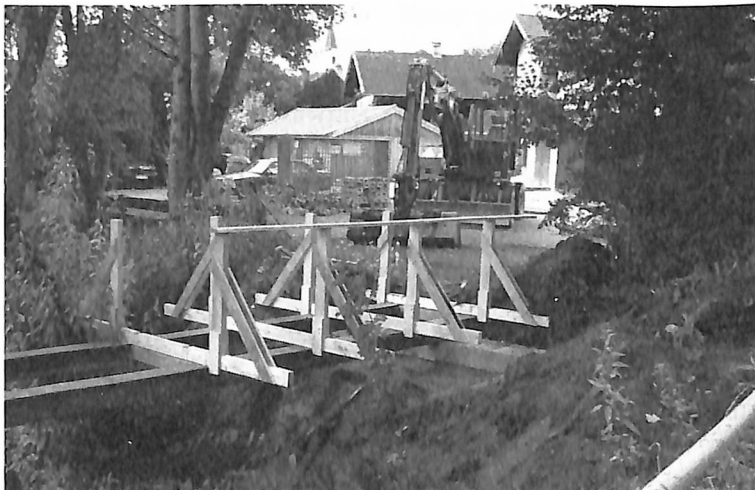
Bevor die alte Brücke zur Siedlung Am Kupferbach abgerissen wurde, erstellte die Firma einen provisorischen Übergang, der den Anliegern am Schmiedberg regen Umleitungs-Verkehr erspart.
