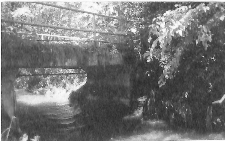
Die Brücke zur Siedlung Am Kupferbach wurde mittlerweile wieder mit einem Unterbau für den Schwerlastverkehr befahrbar gemacht. Im nächsten Jahr wird sie neu gebaut.
