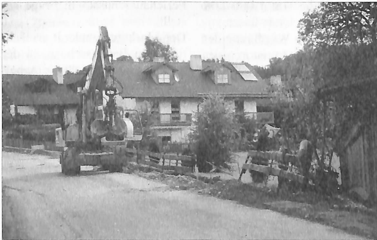
Im Juli wurde mit den Arbeiten am Gehsteig Wolfgang-Koller-Straße begonnen. Fotos: kk
