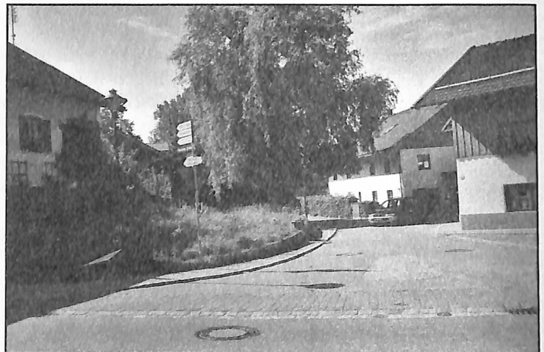
Eine problematische Parkplatzsituation erwartet der Bauausschuss nach dem Abriss des Anwesens und dem Neubau einer Wohnanlage an der Rotter/Haslacher Straße. Foto: kk
