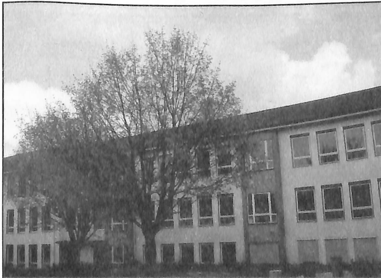
Das Dach der Volksschule Glonn kann künftig zur Solarstrom-Erzeugung genutzt werden - die Gemeinde stellt die Fläche zur Verfügung, die Bürger investieren in die Anlage. Foto: kk
