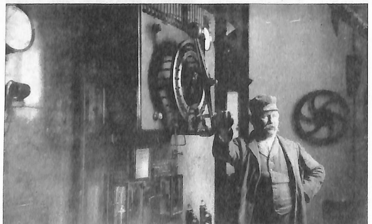
Peter Kastl, der Gründer des Glonner Elektrowerks Altinger, vor einem neu eingebauten Zellschalter. Repro: Hans Obertanner
