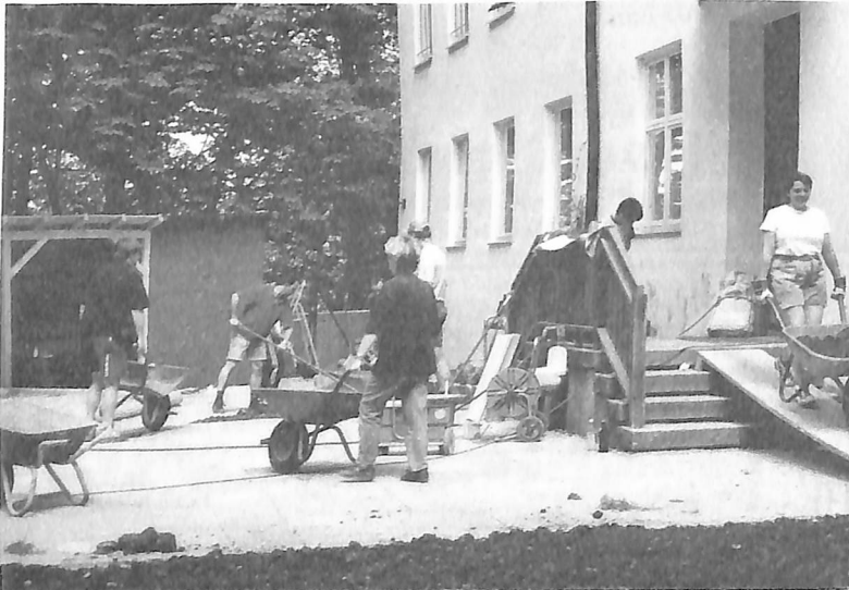
Viel Arbeit und trotzdem gute Laune hatten alle Helfer und das Kiga-Team beim Umbau des Kindergarten-Gartens in Zinneberg. Foto: kiga
