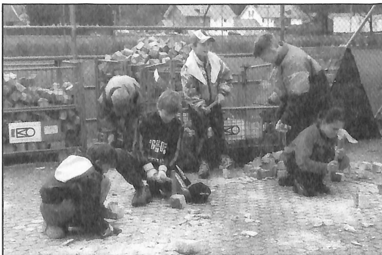
Eigentlich noch eine Baustelle, aber trotzdem schon viel interessanter als das Pflaster vorher ist der Pausenhof der Glonner Volksschule seit Beginn der Umbauarbeiten.
