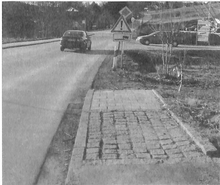
Hier endet der Gehsteig entlang der Kastenseestraße. Eine Weiterführung Richtung Penny-Markt und Baugebiet soll hier gebaut werden. Foto: kk
