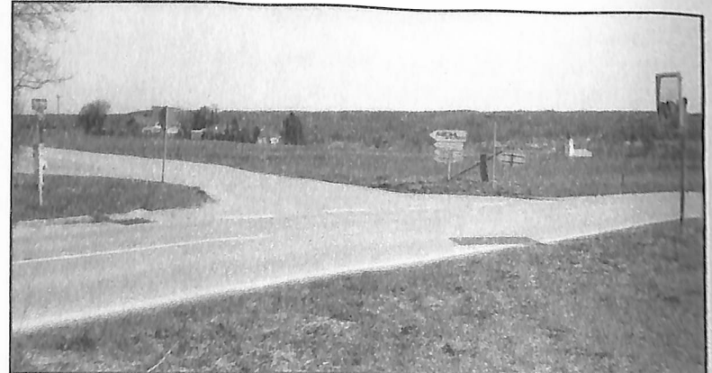
Wenn in Steinhausen ein Gewerbegebiet entsteht, dann muss voraussichtlich auch die Einmündung in die Kreisstraße EBE 14 auf Höhe Balkham neu gestaltet werden.
