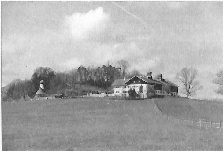
Das Gut und die Kapelle Georgenberg wurden mit viel Eigenleistung und Hingabe von den neuen Besitzern saniert. Foto: kk
