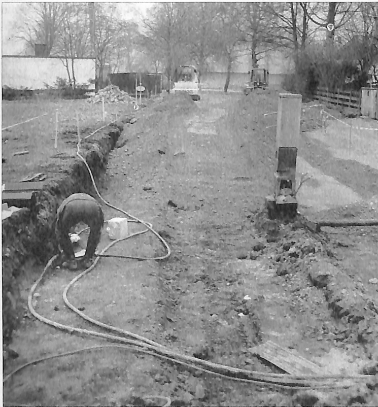
Zeitweise unbefahrbar sind die Straßen im Gebiet Wiesmühl-/Kugelfeldstraße. Hier ist vor Verlegung der Kanäle und Leitungen ein kompletter Bodenaustausch nötig. Foto: kk
