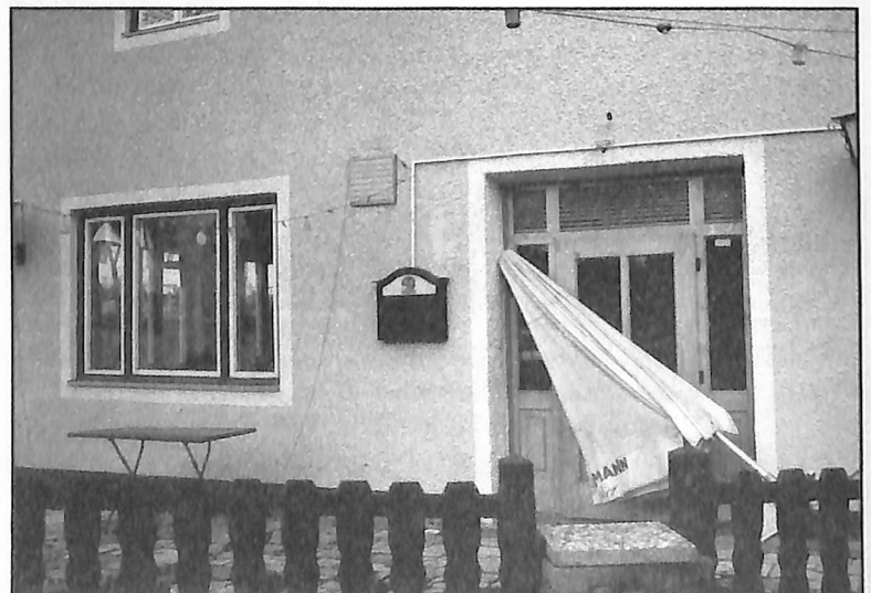
Ziemlich zu schaut es schon seit geraumer Zeit im ehemaligen Fire-House in der Feldkirchner Straße aus. Von den Verkaufsabsichten der Widmann-Brauerei ist auch das Jugendcafé betroffen.
