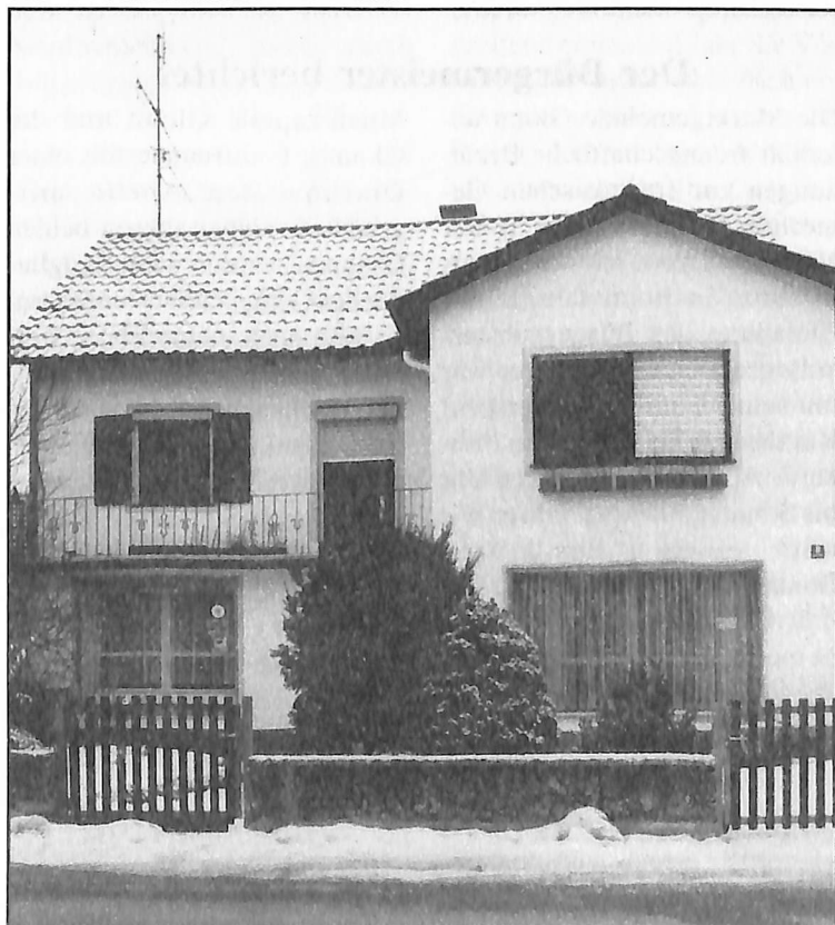
Der ehemalige Friseurladen in der Lena-Christ-Straße wird abgerissen und eine Lehrwerkstatt im Neubau eingerichtet.
