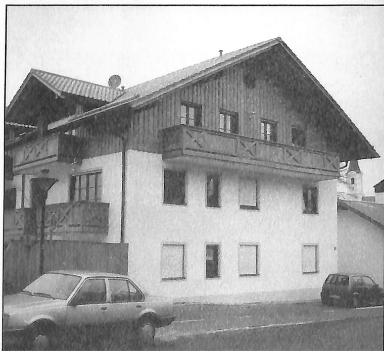
Allerhand Überschreitungen sind bei diesem Neubau in der Feldkirchner Straße festgestellt worden. Der Bauausschuss stimmte nachträglich zu.
