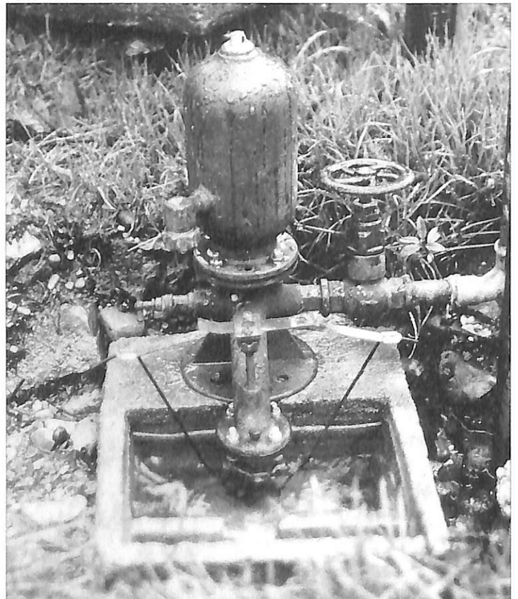
Ein noch immer funktionierender hydraulischer Widder ist der ganze Stolz des Sammlers und Stegmühl-Pflegers Josef Rieder. Foto: kk
