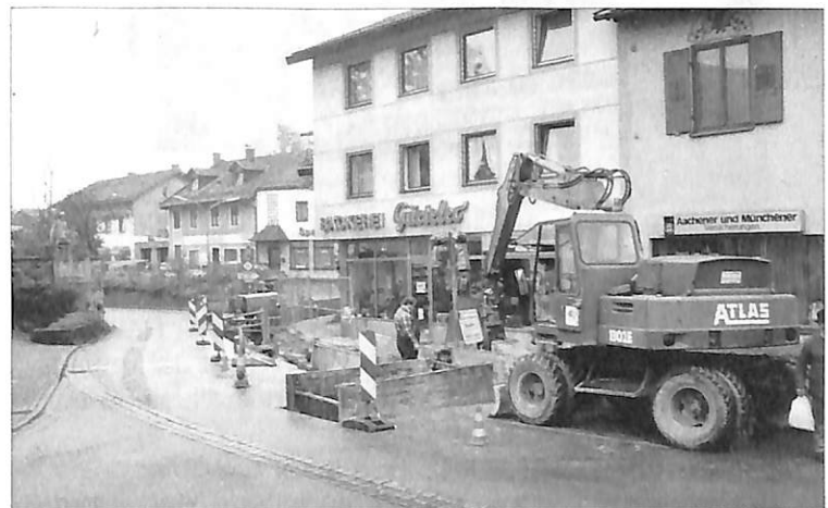
Es geht zügig voran beim Wasserleitungsbau. Die hier abgebildete Stelle ist inzwischen schon wieder überteert.
