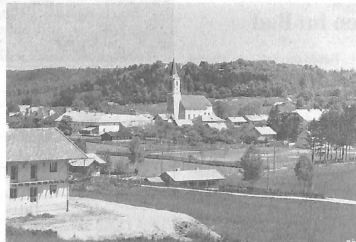
Blick auf Glonn von der Kasteseestraße aus. Das Wohnhaus der Firma Brunner befindet sich gerade im Bau. Foto: hss
