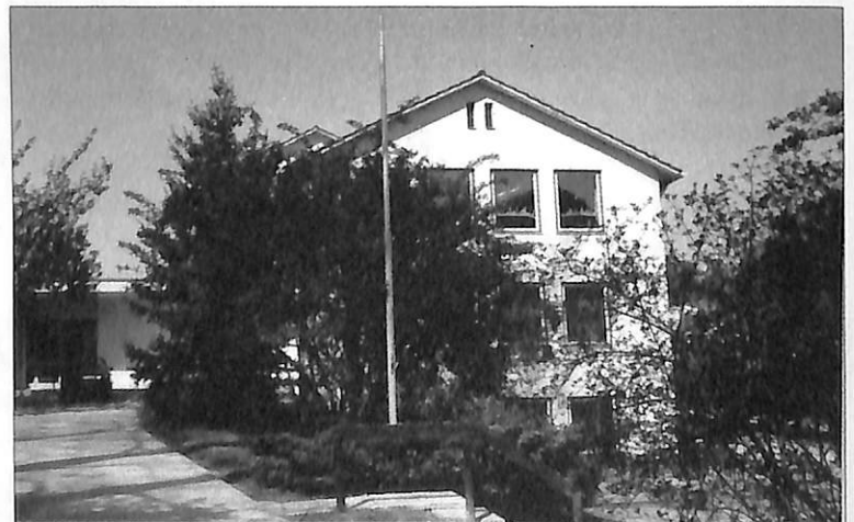
Die Volksschule verursacht 78 Prozent der Energiekosten aller gemeindlichen Gebäude. Foto: kk
