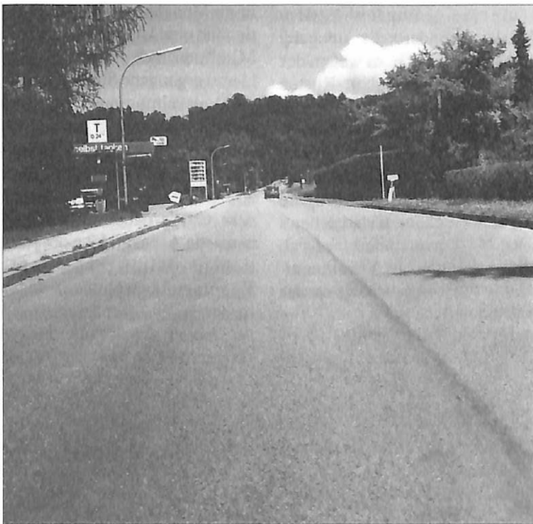
Die schnurgerade Zinneberger Straße lädt am Ortsausgang geradezu dazu ein, aufs Gaspedal zu treten. Mit einer Überquerungshilfe wird es für die Fußgänger demnächst etwas einfacher, auf die andere Seite zu gelangen.
