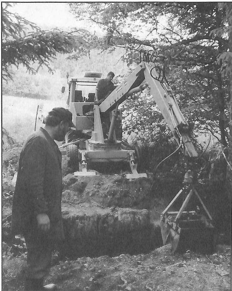
Die Anlieger reparierten die Brücke mit Unterstützung des Bauhofes - die gegenüber angrenzende Gemeinde Aying zahlt dazu ihren Anteil. Foto: Martin Esterl
