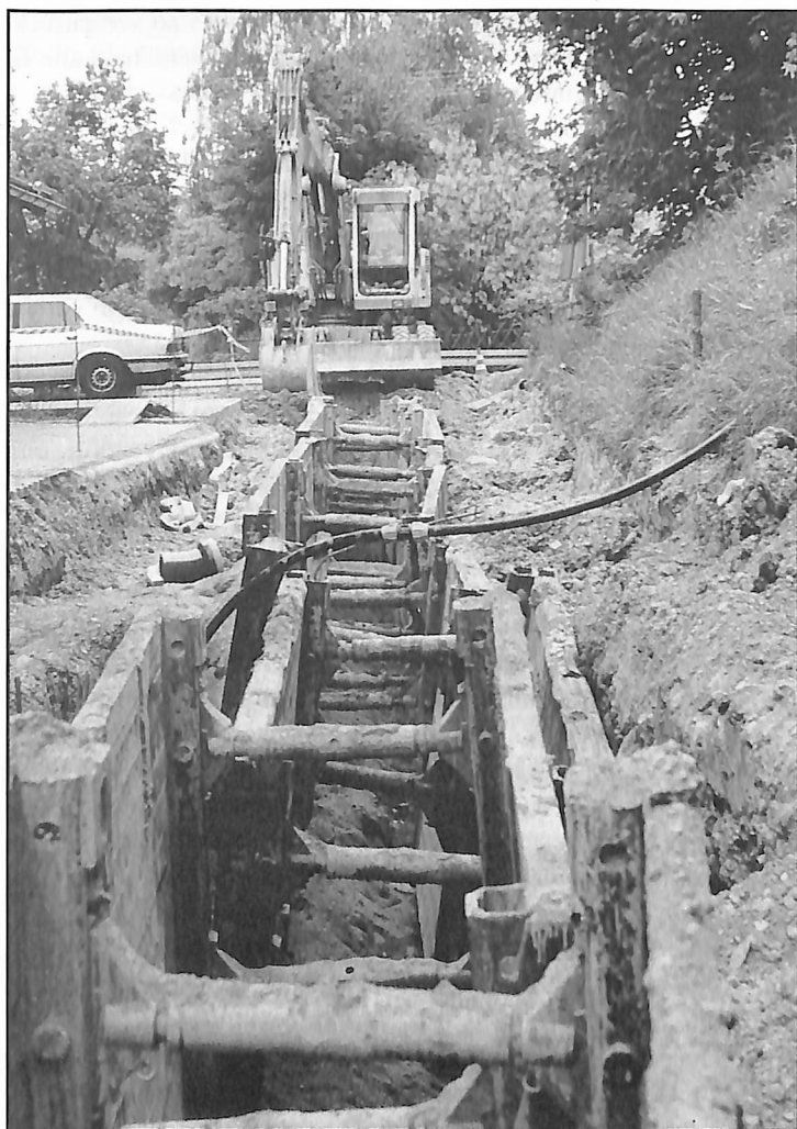
Nur einmal mußte die Straße am Kolomanweg in Haslach aufgerissen werden: Kanal und Straßenbeleuchtung kamen gleichzeitig in den Untergrund.
