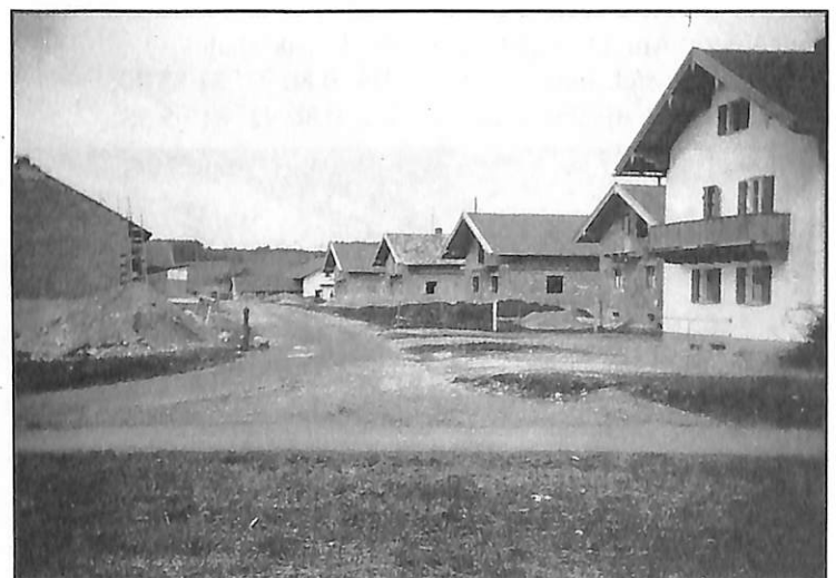
Die Häuser an der Fuggerstraße entstanden in der Nachkriegszeit und linderten die damals krasse Wohnungsnot. Foto: hss
