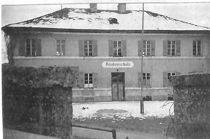
Die ehemalige Knabenschule in Glonn befand sich an der Professor-Lebsche-Straße, wo heute das Sparkassengebäude steht.
