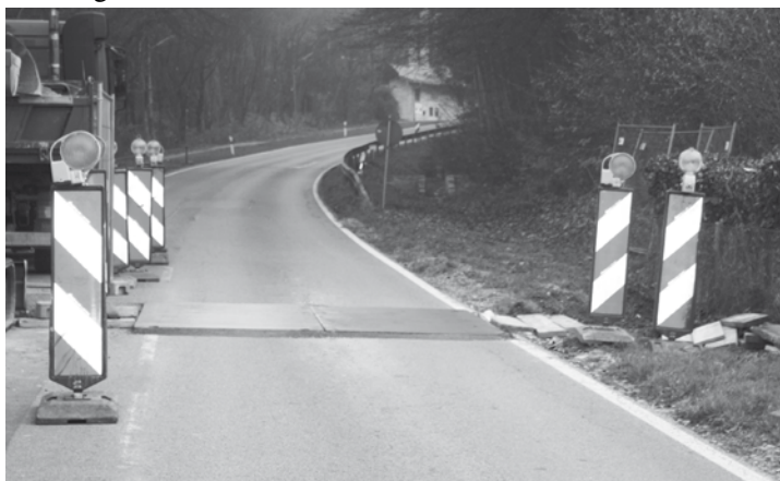
In diesem Herbst konnten fünf Glonner Anwesen, darunter auch der neue Verbrauchemarkt, neu an das Wärmenetz angeschlossen werden. Hier auf dem Foto der Anschluss des Forsthauses an der Zinneberger Straße.
