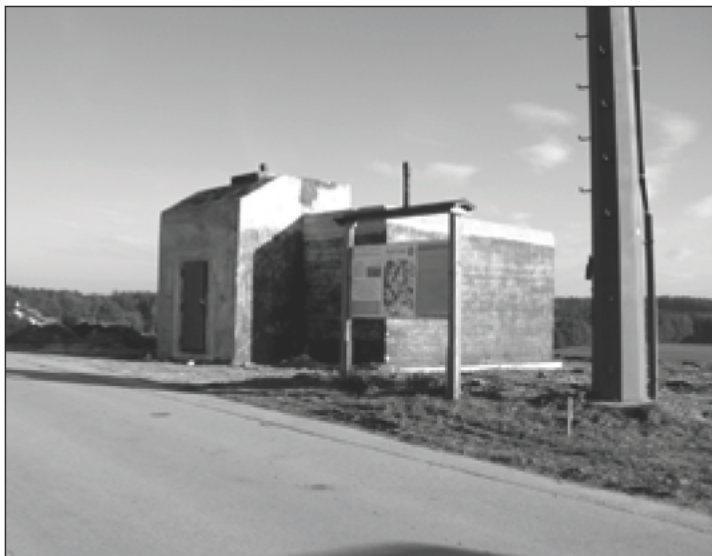
Der alte Wasserhochbehälter wird zum Feuerwehrgerätehaus umfunktioniert. Foto: sk
