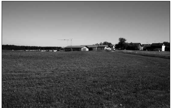
An diesem Standort zwischen der St. 2079 und der Ortsverbindungsstraße Schlacht-Niederseeon wird das Möbelhaus MÖM entstehen. Foto: Gerneth
