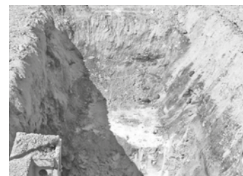
Mitten in der Lena-Christ-Straße beim Kanalbau aufgelassener Steinbruch gefunden.
