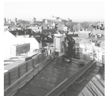
Anspruchsvolle Arbeit mit besten Aussichten. Dennis Leicher installiert über den Dächern von München eine Serverraumklimaanlage.
