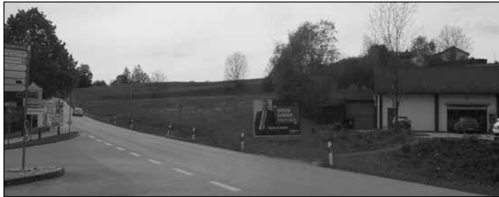
Neben dem alten Penny entsteht der neue Penny
