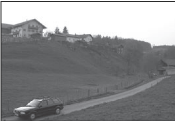
Eine noch höhere Gefährdung des Hanges befürchten die Anwohner von Steinhausen, wenn südlich der Ortschaft die geplante Retentionsfläche verwirklicht werden würde. Foto: sk
