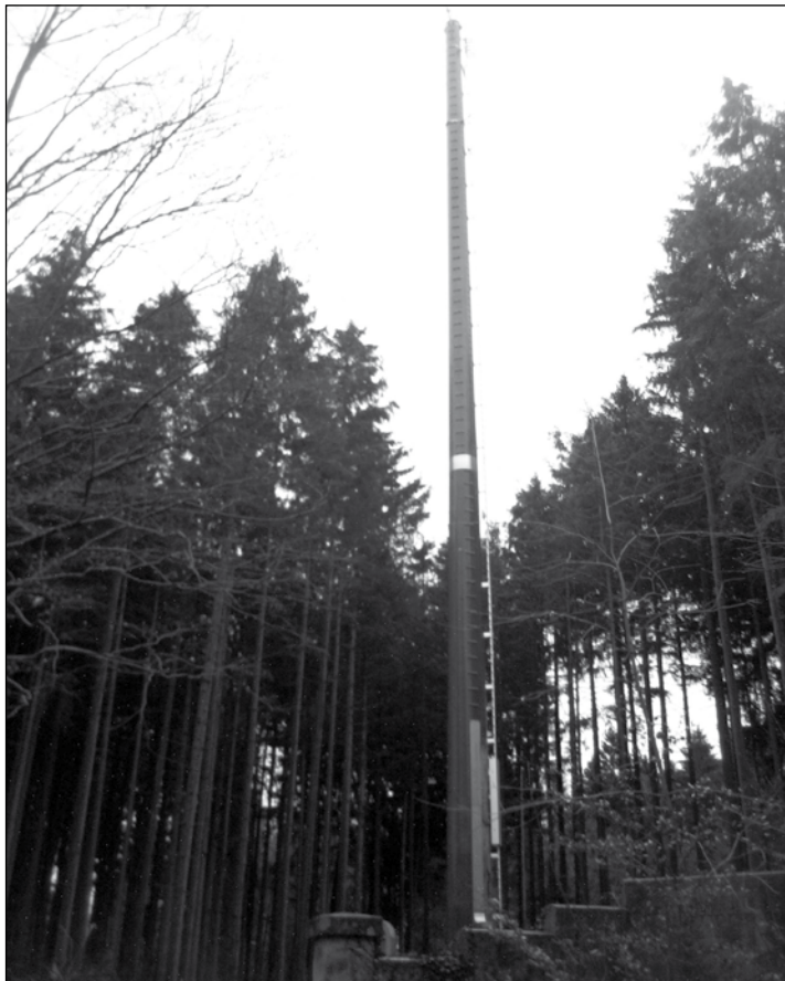
Mitten im Wald an der Zinneberger Mauer, von der Straße aus kaum zu sehen, steht der neue BOS-Sendemast. Foto: Martin Esterl
