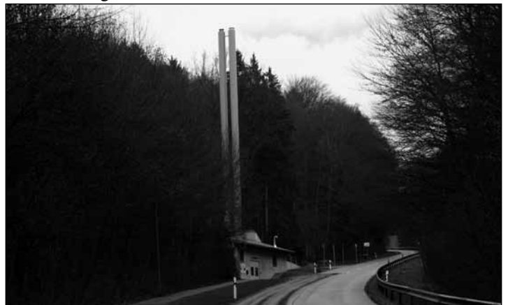
Das Holz hackschnitzel-Heizwerk arbeitet mustergültig – so das Fazit der Betreibergesellschaft. Foto: Gerneth
